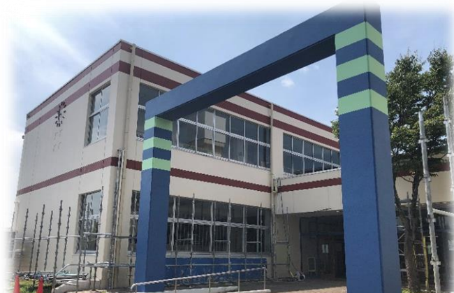
夏休み中に外壁工事が終わって、外装がとてもきれいになりました！（青春の門より）
